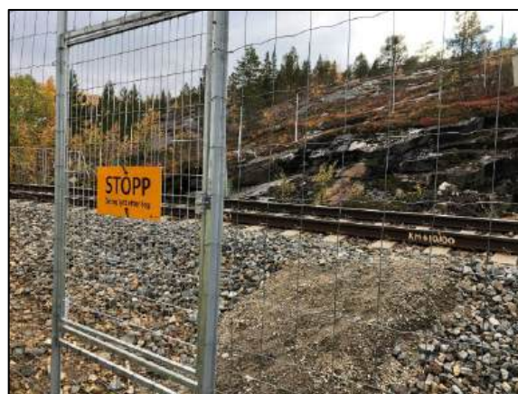
Figur 4 Eksempel på rømnings-/inspeksjonsport.
