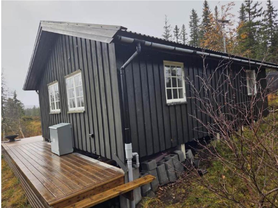
Figur 4 Hytta fra øst. Vinduene på den østlige veggen (kortenden) ønskes skiftet ut med fire større vinduer, målt til 1000 \times 1800 mm, uten sprosser.
