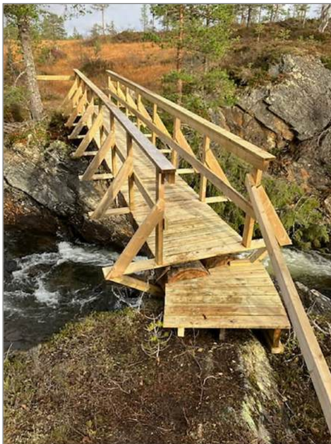
DNT Trøndelag har sammen med frivillige gjennomført arbeid med å bygge en ny bru over Storbekken, i tilknytning til Malsåstien i Verdal, Blåfjella–Skjækerfjella nasjonalpark.
