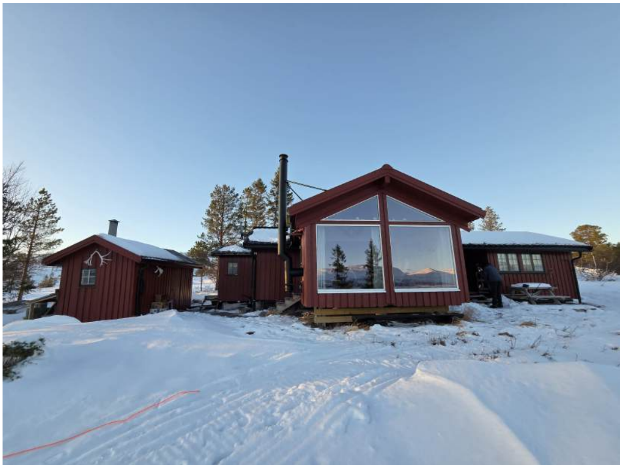
Figur 2: Bilde av hytta og uthus, med utedo/bod i utbygg mot uthuset (til venstre i bildet).
