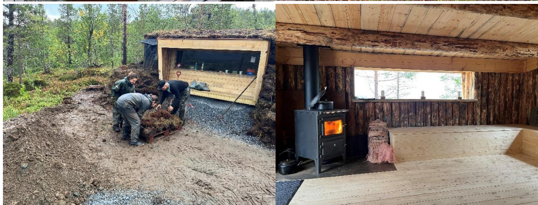
Bilder fra bygging av gammen. Foto: Ingve Birkeland.
