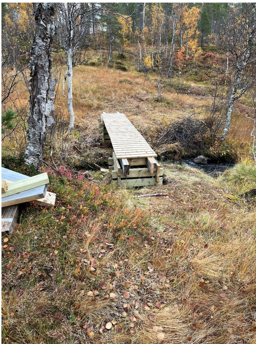
Arbeid med bygging av bro ved Andre Velten i forbindelse med omlegging av stien i området. Foto: Ingve Birkeland.
