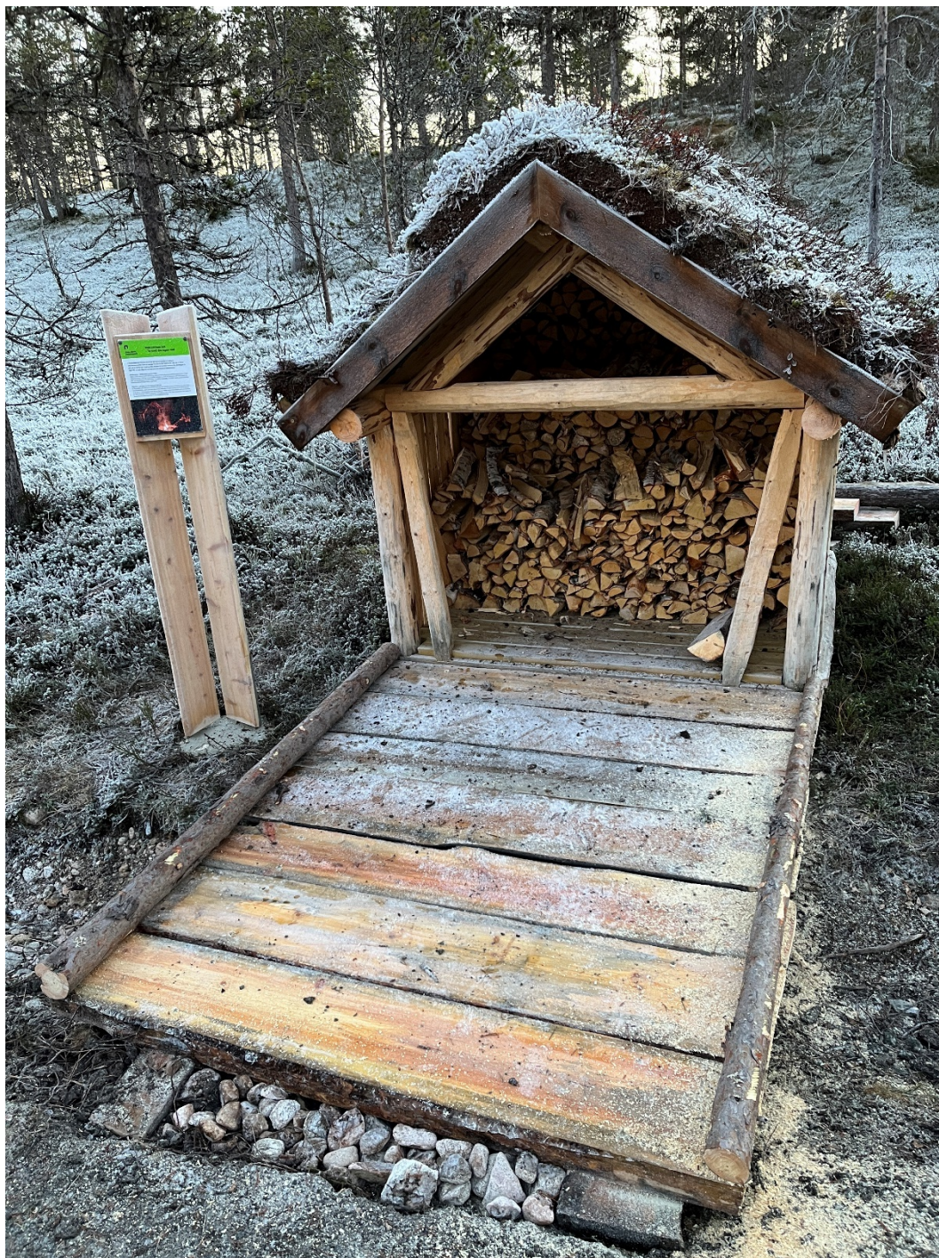
Arbeid med universell utforming av vedskjul langs den universelt utformede stien. Nytt skiltstativ for miniplakater. Her skal vi teste ut konseptet med at de besøkende oppfordres til å ta med ved innover til bål plassene lengre inn i innfallsporten- Foto: Ingve Birkeland.
