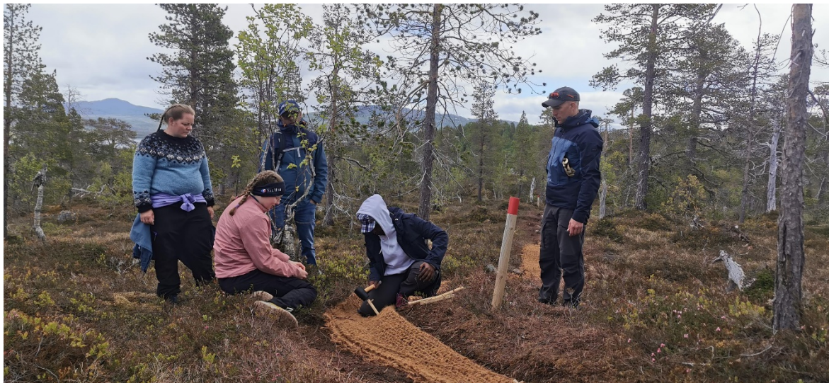
Elevene fikk informasjon om bærekraftige stier og hjelp til med å legge ut kokosmatter og furuflis på stisegment på rundløype i Tranøybotn. Foto: Fredrik Jenssen (Fjelltjenesten).
