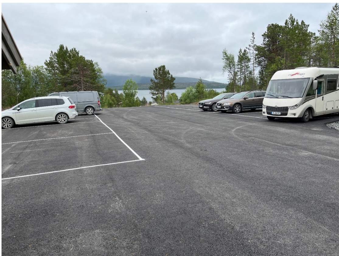
Ny asfalt på parkeringsplassen i tilknytning til innfallsporten i Tranøybotn. Foto: Ingve Birkeland.
