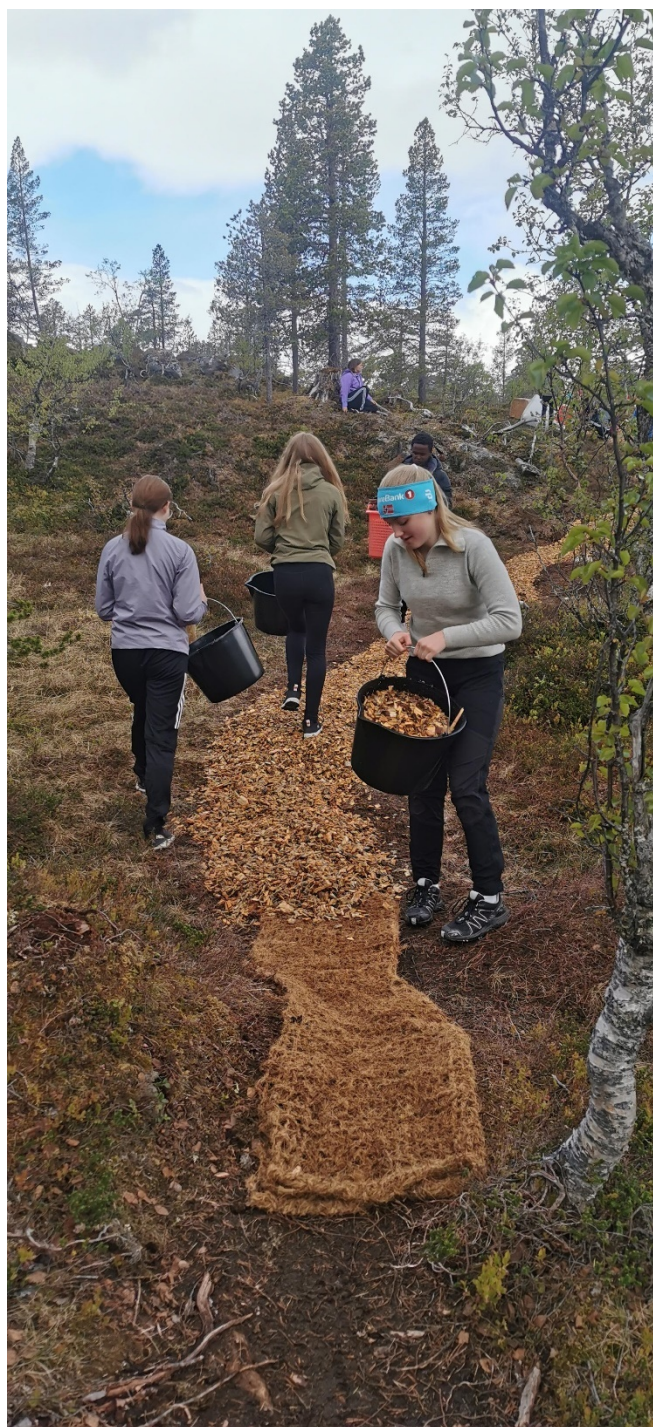
Ivrigt elever i arbeid med å etablere en bærekraftig sti. Foto: Fredrik Jenssen (Fjelltjenesten).
