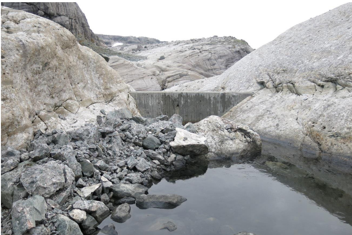
Bilete 13: Sperredam i nærleiken av bekkeinntaket i Skordalen. Sperredammen er om lag 5 m lang, og er bygd av SFE i samband med bekkeinntaket. Foto: Alf Erik Røyrvik
