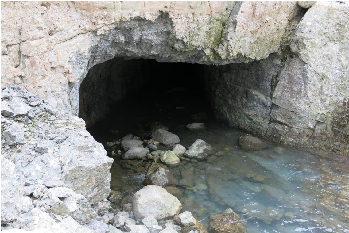
Bilete 12: Bekkeinntak oppunder breen i Skordalen som fører vatn over til X-vatn og vidare mot kraftverket i Åskåra. Det er Sogn og Fjordane Energi (SFE) som driv kraftanlegget. Foto: Alf Erik Røyrvik
