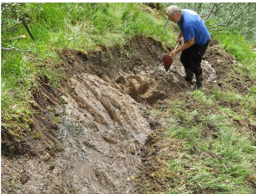
Bilete 6. Egil Ravnstad frå Bygdeservice jobbar med stien frå Hope til Lavesteinen. Dei fjerna torv og jord slik at ein kom ned på bart fjell som er lettare og tørrare å gå på. Det betydde mykje tungt fysisk arbeid!
