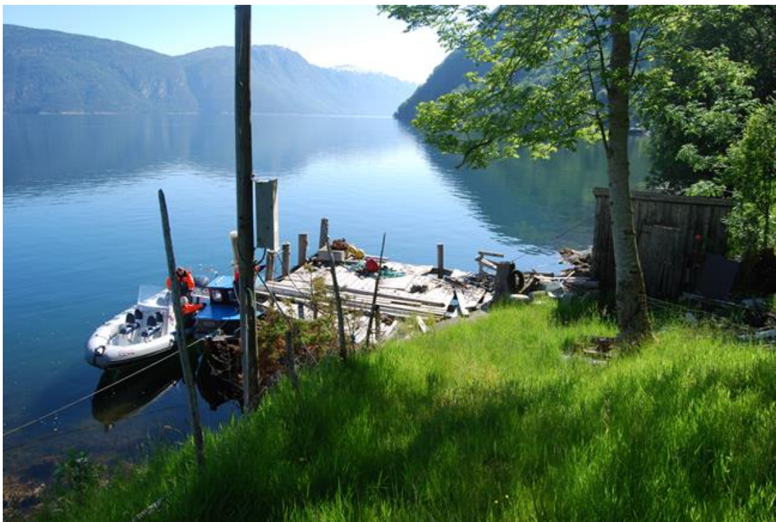
Bilete 4. Den gamle kaia på Mettenes der det no skal byggast molo. (bilete frå 2012)
