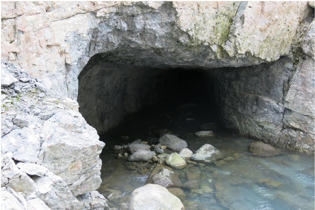
Bilete 5. Bekkeinntaket i Skordalen.
