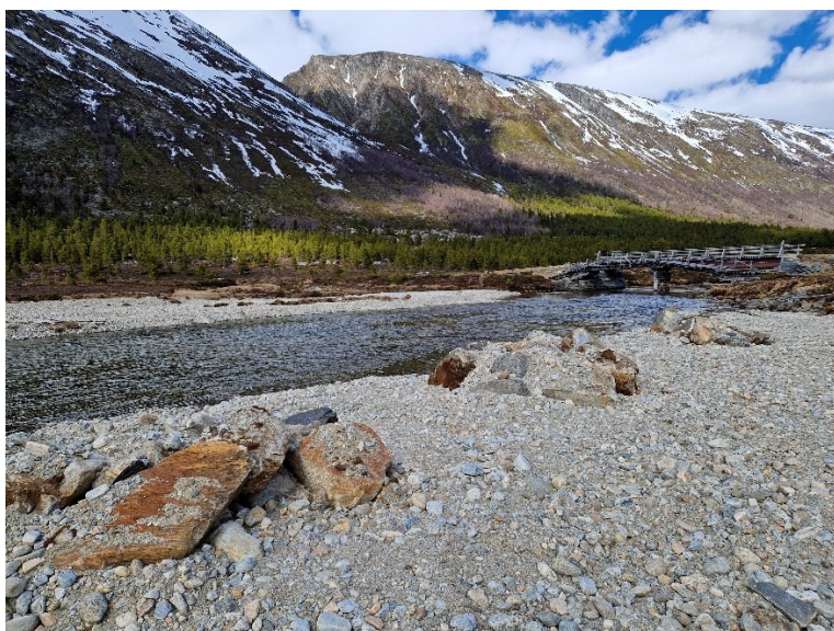
Foto: grusmassar lagt opp i elvekanten mot vegen, og bygging av buner oppstrøms Sterringen bru.
