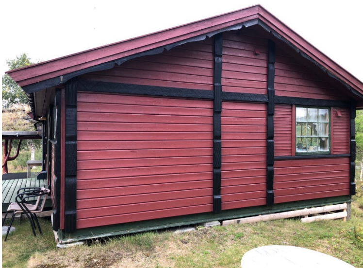
Bilde 4: Fasade østvegg. Denne delen av dobbelthytta eies av Robert Hasselbergesen. Kilde: Hyttekartlegging Saltfjellet- 2018.
