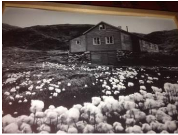
Foto frå søknad. Bygg frå 1953
