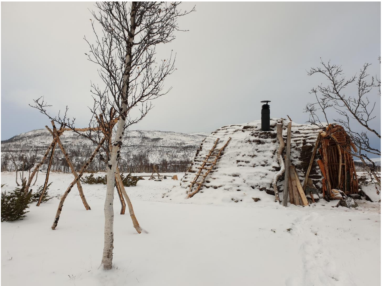
Bilde: Gamme ved Saivva i Navitdalen Ivo. Tradisjonell utforming med bjørk, never og torv. Bygget av John Ivar Larsen på oppdrag fra verneområdestyret.
